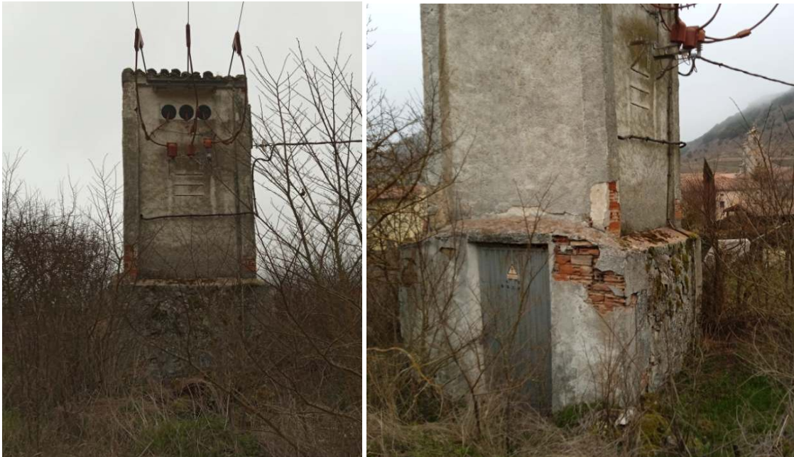
Foto del edificio a demoler
